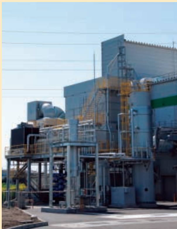
今回導入したVOC対策装置（有機溶剤回収装置）
