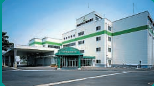
④ 本社・新工場(埼玉県)
